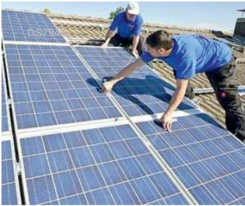
L'installazione di pannelli fotovoltaici su un tetto (archivio/ Photopresse)
