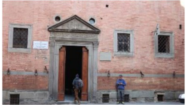
A Palazzo Bandini Piccolomini erano le segreterie; nei sotterranei il Centro di calcolo
